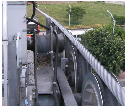
Figura 4. Poleas de pilonas de soporte
