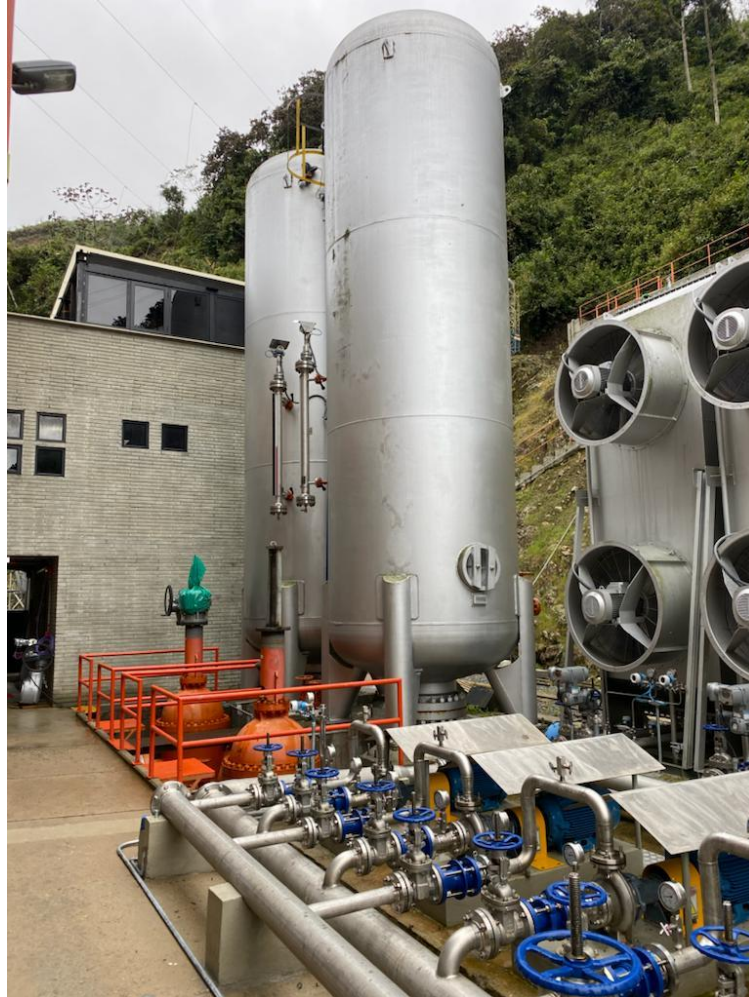
Figura 5. Tanques hidroneumáticos.
