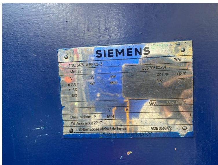
Figura 19. Datos de placa planta Rio Piedras Bomba Grupo 2. Fuente: Elaboración propia. Fotografía tomada en visita a la planta.
