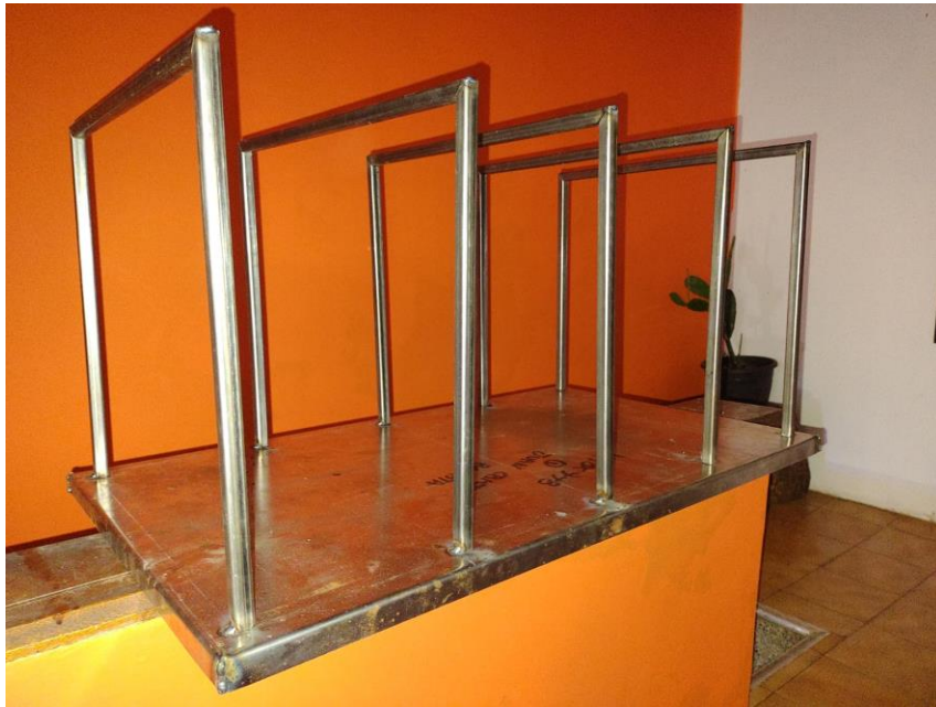
Figura 14. Ensamblaje de las columnas con el suelo.
