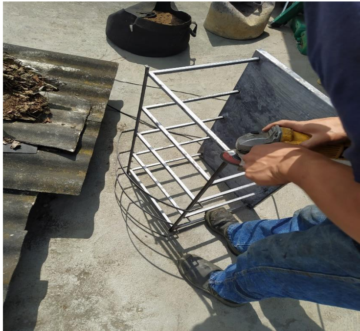
Figura 15. Soldando las vigas a la estructura inicial.
