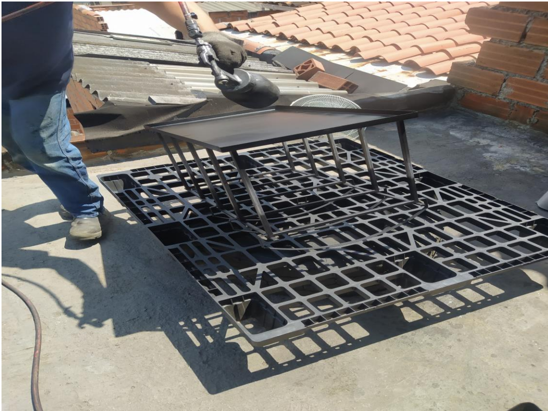
Figura 14. Aplicación de pintura anticorrosiva a toda la estructura.
