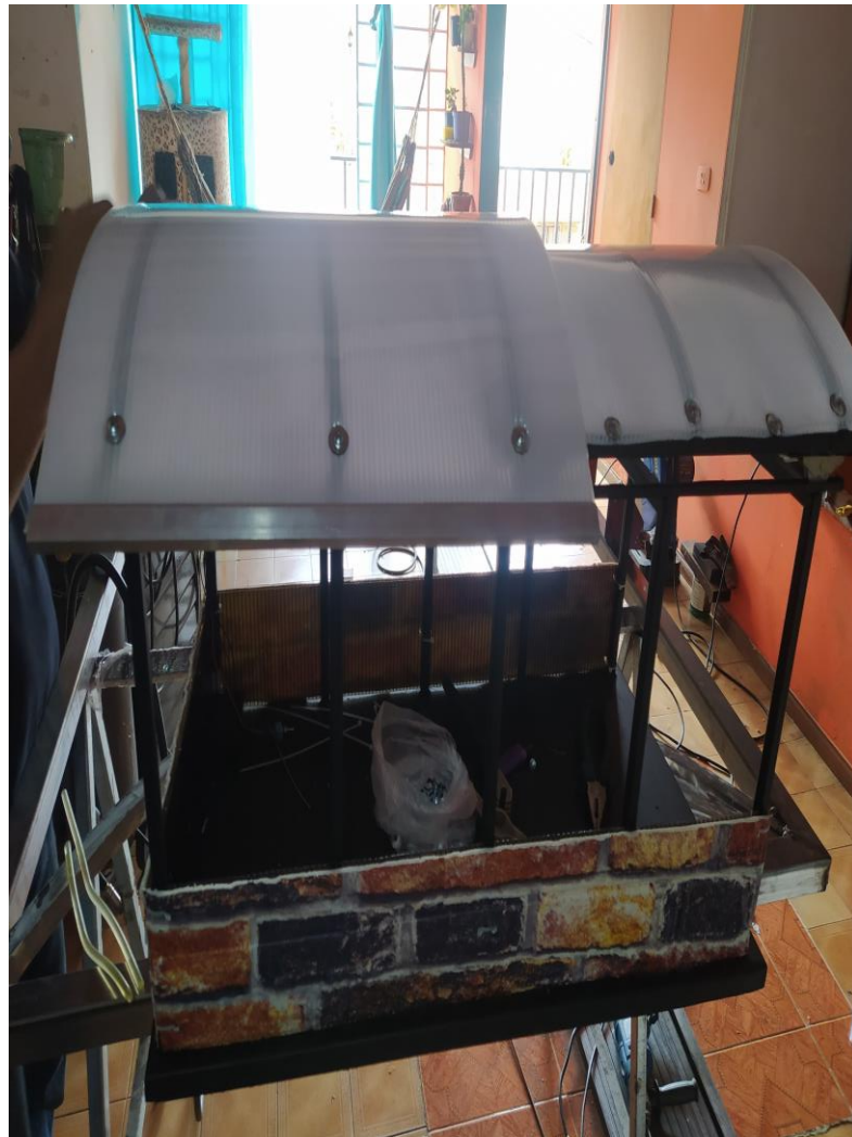
Figura 15. Fijación lámina policarbonato y muro protector
