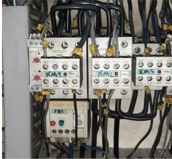
Figura 15. Arrancador estrella – delta del motor.
