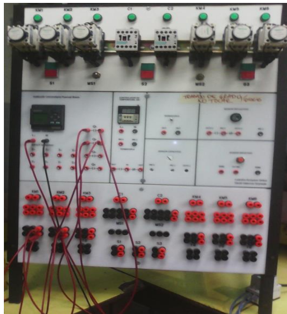
Ilustración 64. Estructura metálica con el PLC y sus demás componentes
