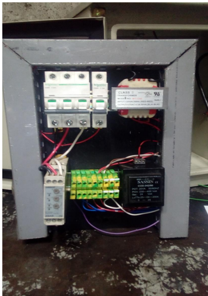
Figura 12. Instalación de componentes Fuente. Propia
