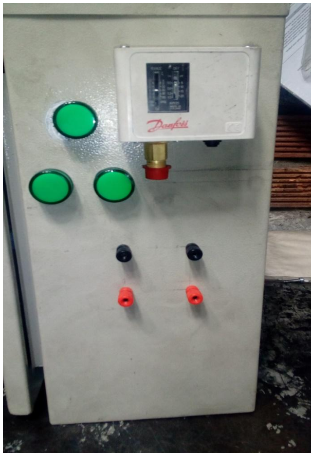
Figura 13. Instalación componentes parte externa Fuente. Propia
