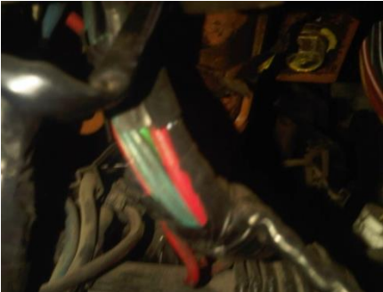
Cableado del swiche
