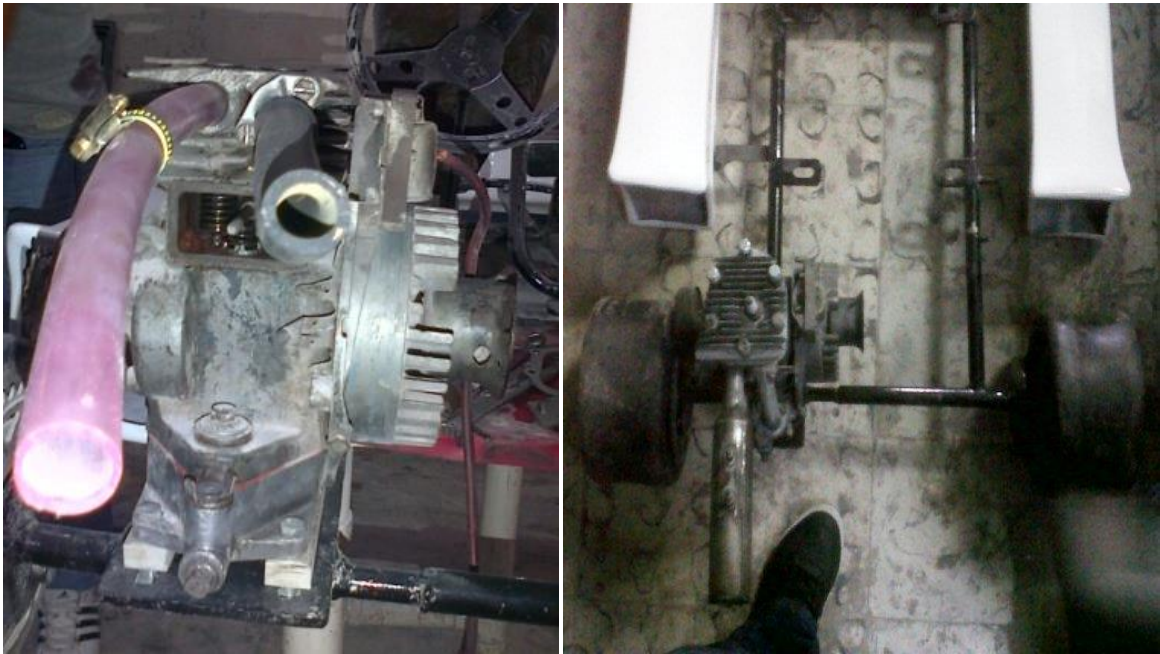
Figura 12: Fotografías Sistema de Alimentación y Escape
