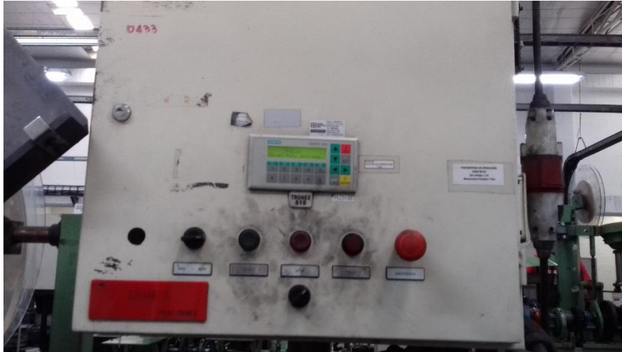
Figura 10. Es el que controla cuando el vaso está posicionado para la inyección de mezcla, (Computador controlador de inyección de mezcla).
