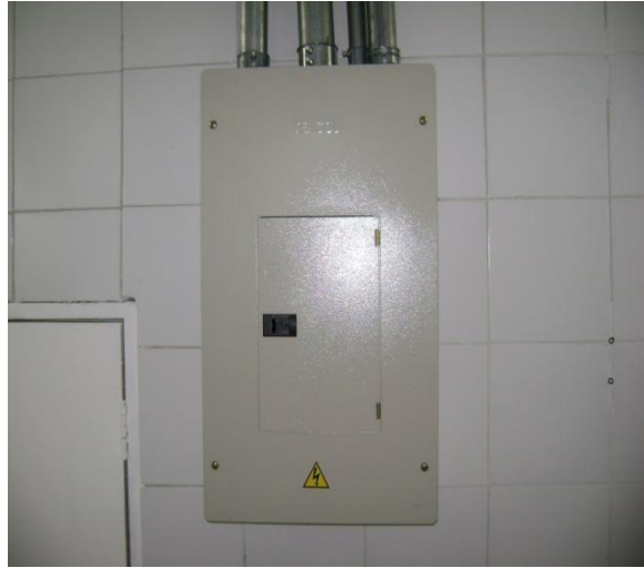
Figura 12. Sistema de alimentación de energía maquinas Saturno
