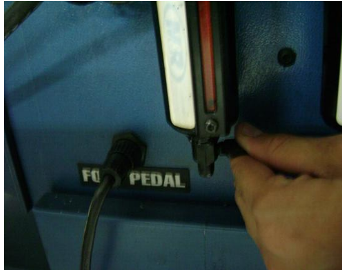
Figura 26. Válvula purga unidad de mantenimiento
