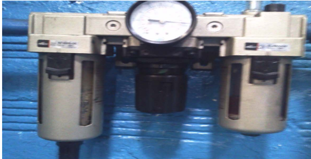
Figura 11. Unidad de mantenimiento del aire del compresor
