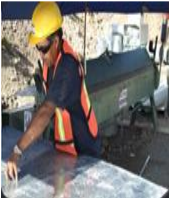
Foto 7. Fabricación de ductos
