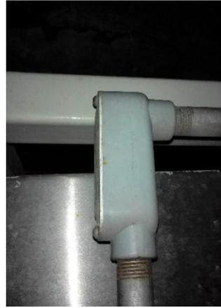
Cambio de conduleta EMT reventada en bomba dosificadora de bactericida, para esto se cambió la tubería y se desconectaron los motores para reconducir los cables a través de la conduleta.
