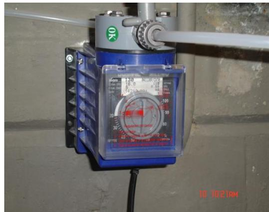
Se reemplazó la bomba dosificadora # 2 de polímero aniónico; debido a que presentaba daños irreparables.
