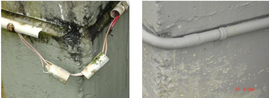
En la figura 17 se puede apreciar el mal estado de la tubería que conduce el cableado del sensor de nivel del tanque de pits, está no contaba con las normas de seguridad requeridas. La tubería fue reemplazada y además se realizaron trabajos de obra civil como pintura y resane de los muros. Para ello se solicitó a la empresa la ayuda del personal de mantenimiento locativo.
