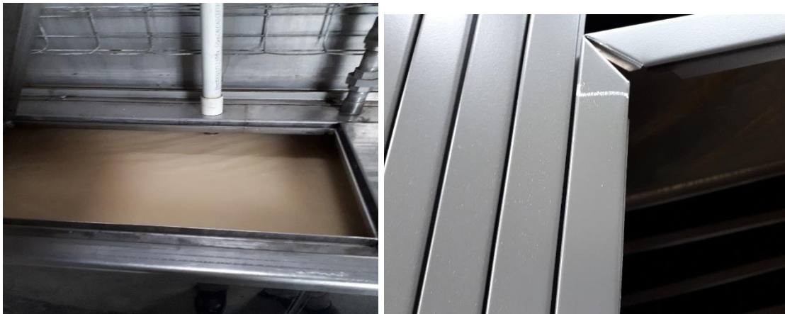
(zapata, fuente propia, 2018)
