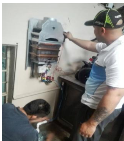
Figura 9: Montaje de equipo generador.
