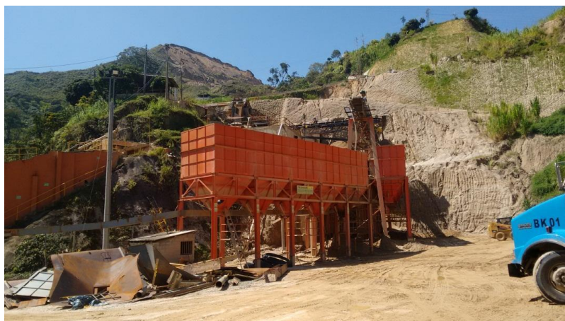
Imagen 8: tolvas de almacenamiento de arena de la empresa.
