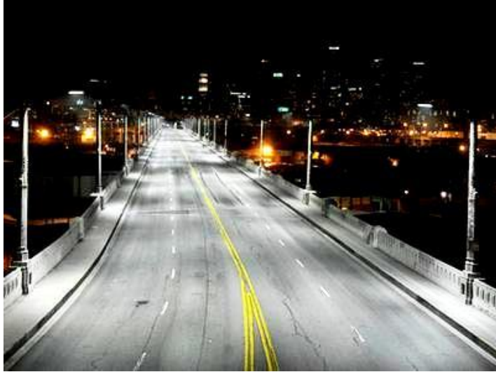
Figura 17. Autopista 1 con luminarias tipo led.
