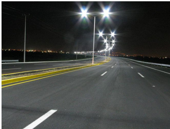
Figura 18. Autopista 2 con luminarias tipo LED.
