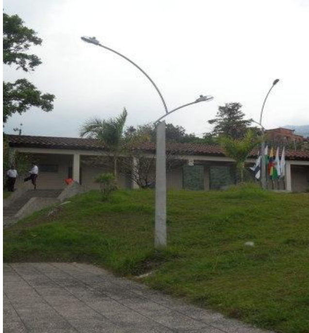
Figura 20. Detalle luminaria plazoleta
