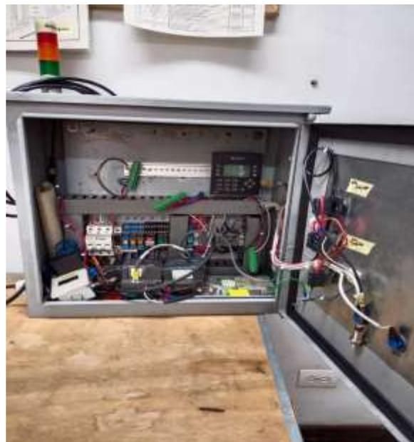
*Figura 20.*Parte interna del tablero
