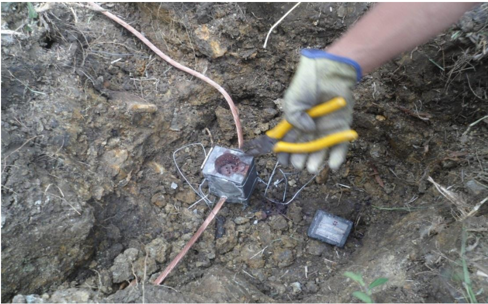
Figura 17. Desarme del molde.
