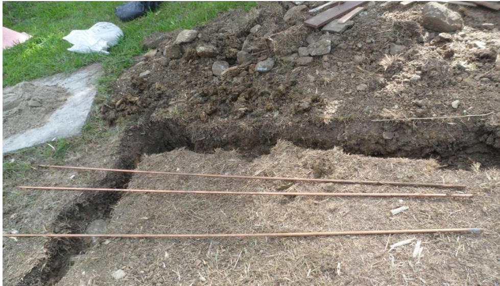
Figura 11. Electrodo de cobre de longitud 2.4 m.
