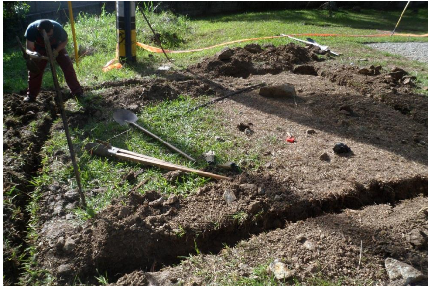
Figura 10. Ejecución de la Cuadrícula de la Malla de Puesta a Tierra.
