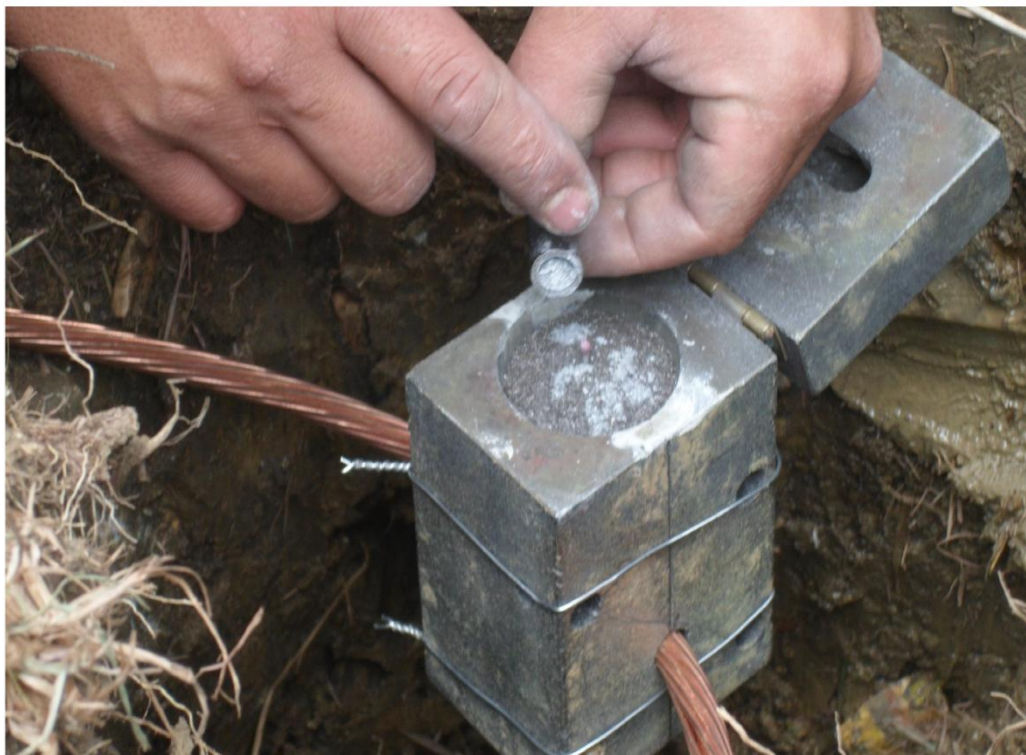
Figura 13. Soldadura en proceso.
