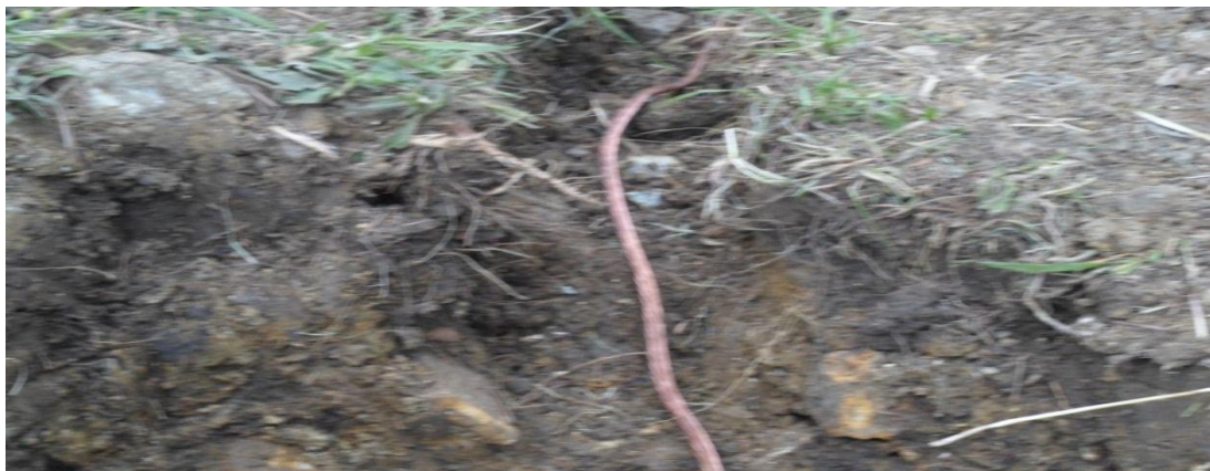
Figura 12. Instalación de cable
