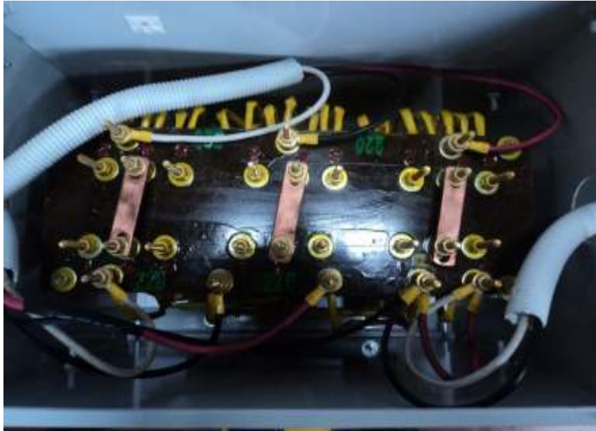
Gráfico 20. Conexión interna trafo 1
