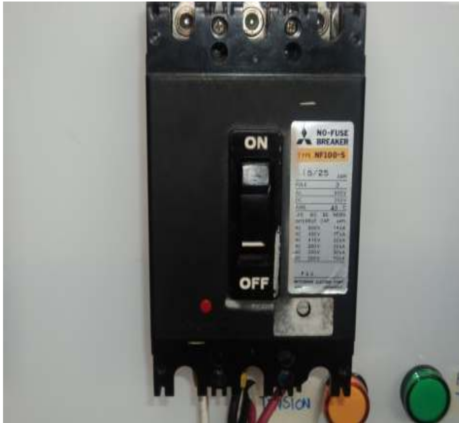
Gráfico 15. Protección trifásica (4 en total)
