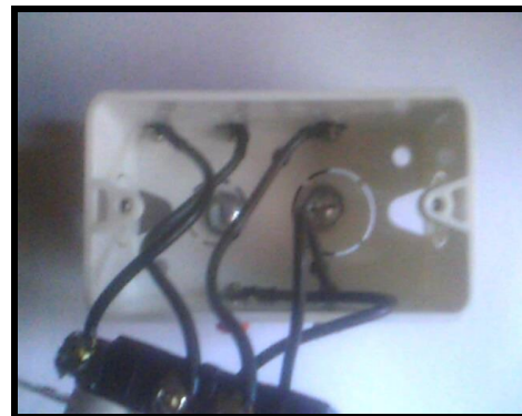
Figura 25. Caja con conexión borneras hembra
