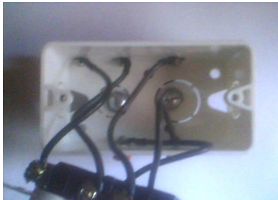
Figura 11. Conexión eléctrica de la caja rectangular plástica
