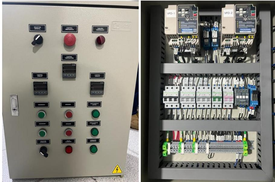
*Tabla 11.* Controles de proceso, indicadores de funcionamiento y sistema de pulsadores para el control del horno.
