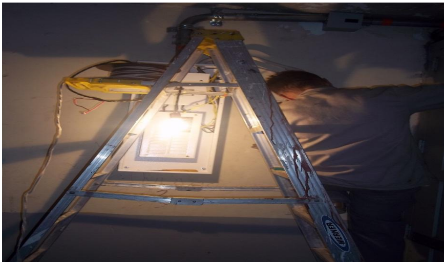
Figura 14 Conexión de los circuitos al nuevo tablero de distribución
