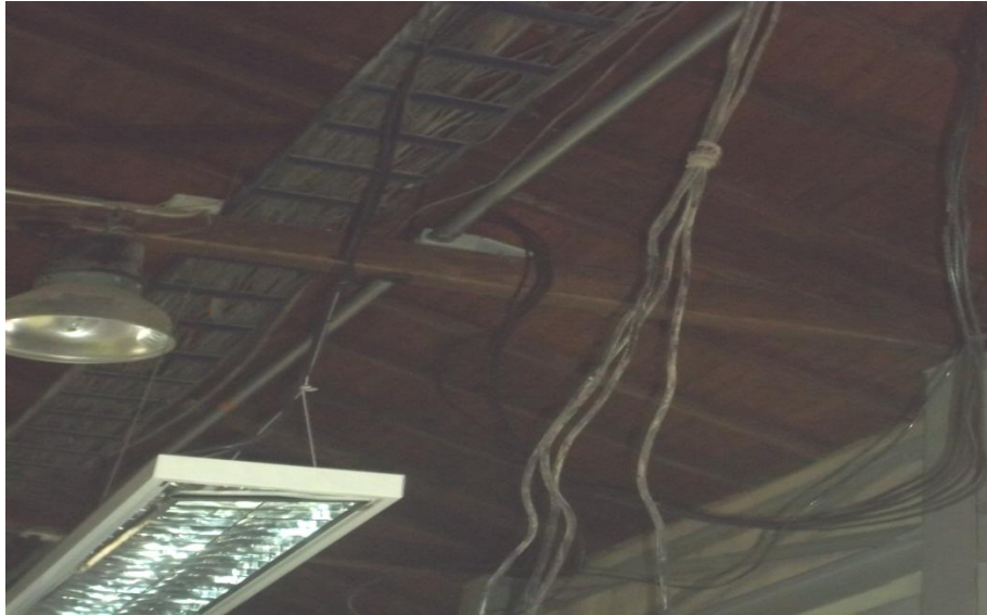
Figura 9 Acometida por la tubería de 2
