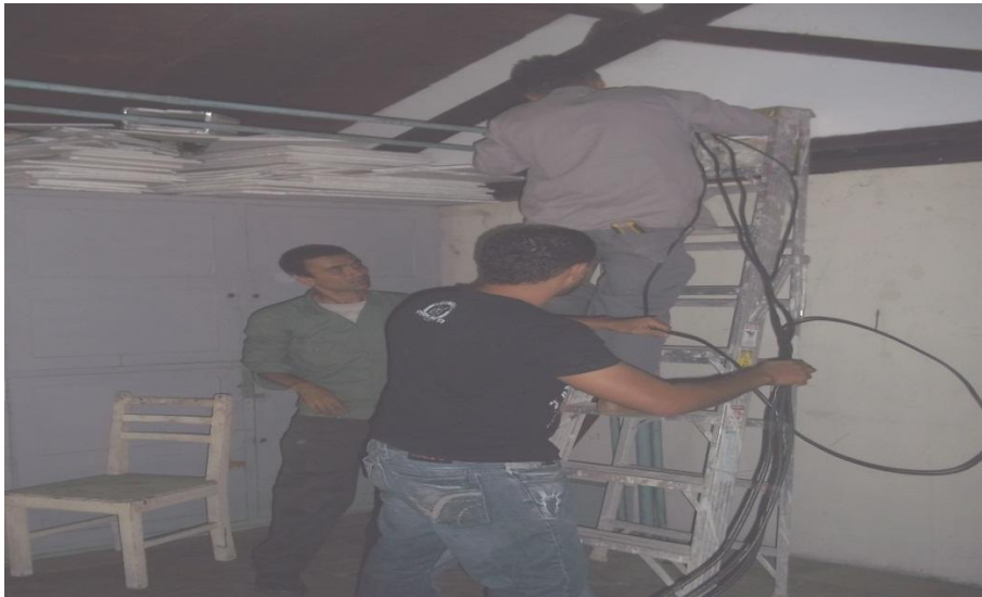
Figura 7 Segundo piso del taller de eléctrica
