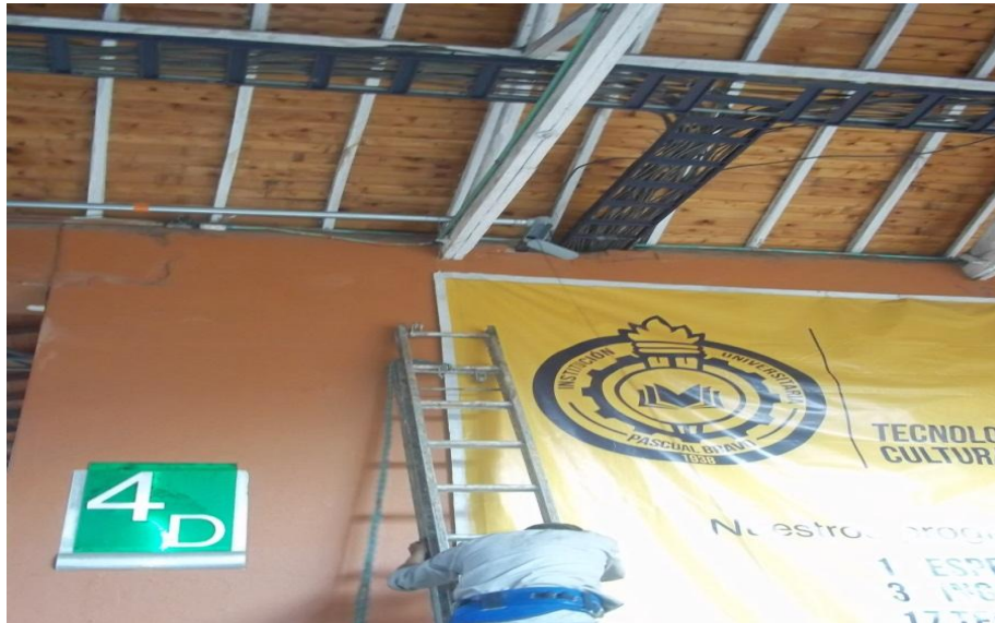
Figura 11 Subiendo a pescar el cable
