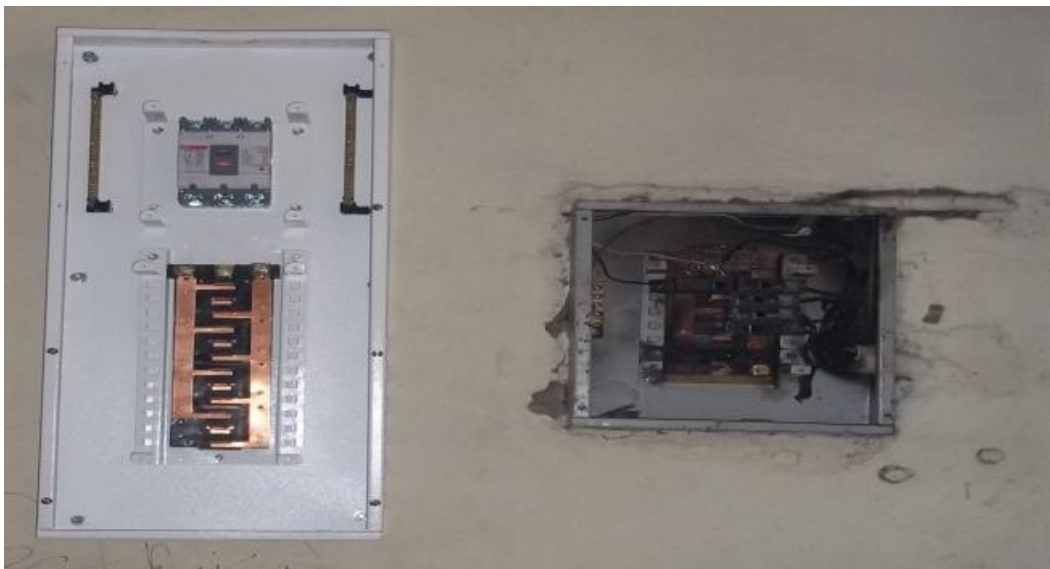
Figura 6 Tablero de distribución nuevo
