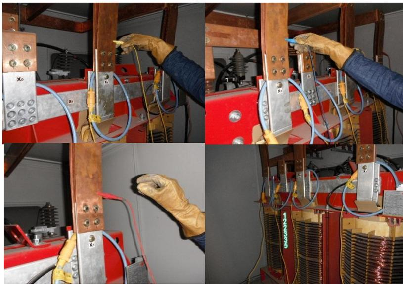
Figura 17. Procedimiento de instalación del analizador
