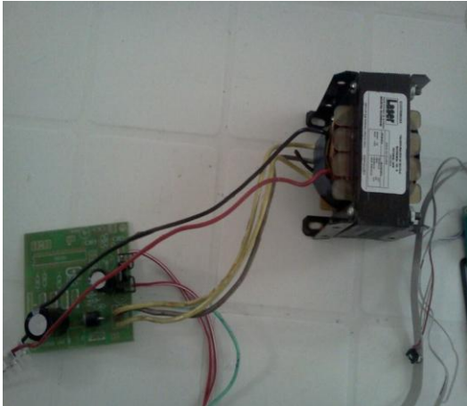
Imagen 25 Alimentación de Inyectores y Bomba. Autor
