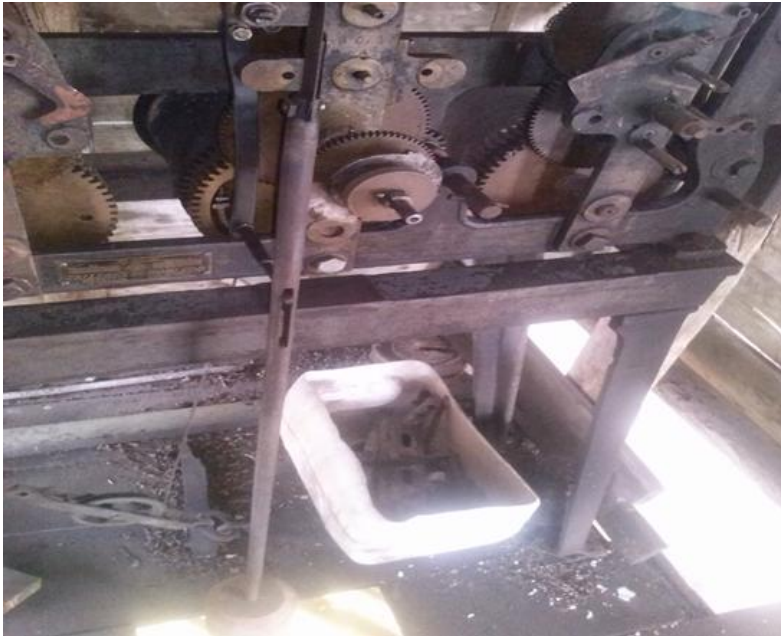
Figura 20. Desmonte de las piezas dañadas del reloj
