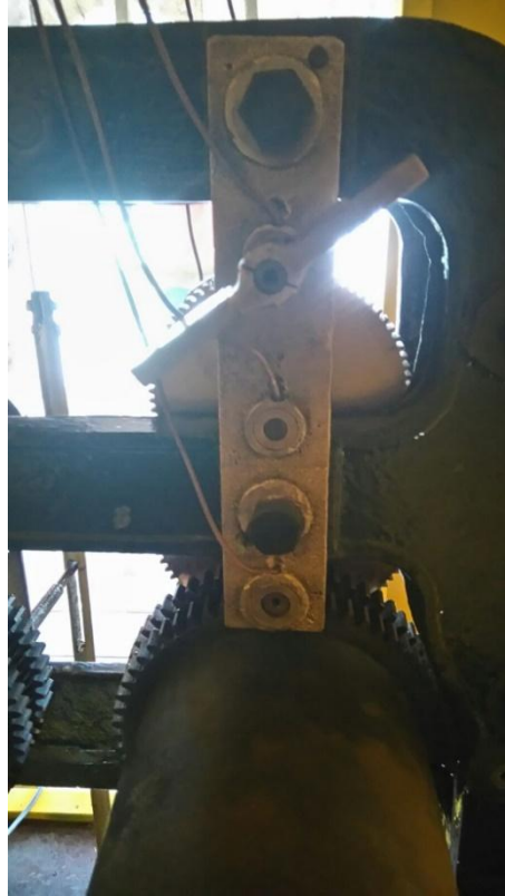
Figura 29. Bloque C con los capilares instalados
