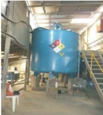
Imagen 8. Tanque de Precipitación Fuente: Elaboración propia
