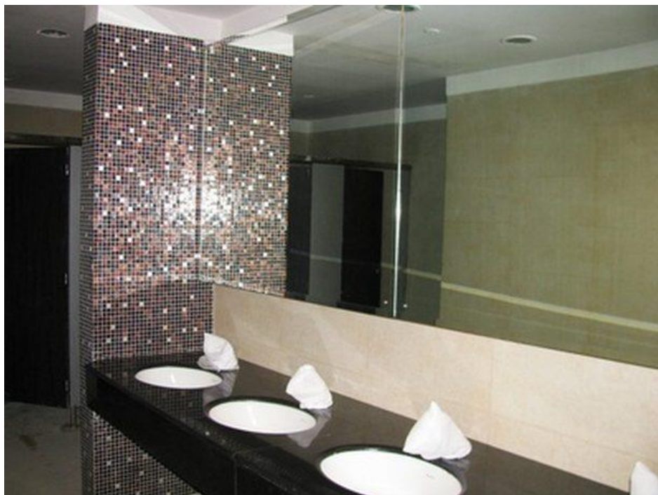
Figura 9 Grifos automáticos en los baños públicos
