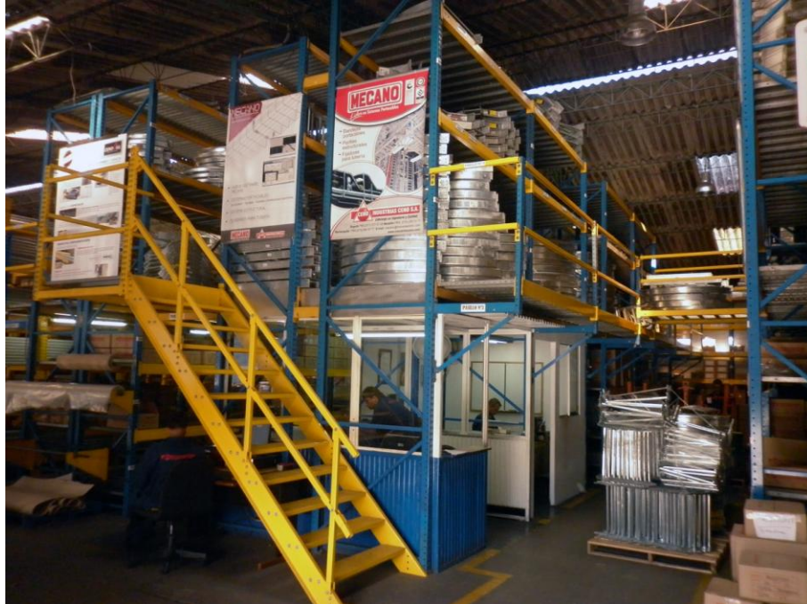
Imagen 6. Mezzanines y Entrepisos.
