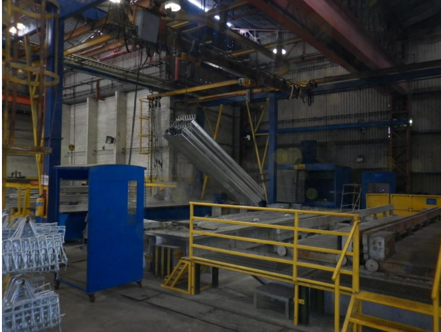
Imagen 19. Planta de galvanizado en caliente.
