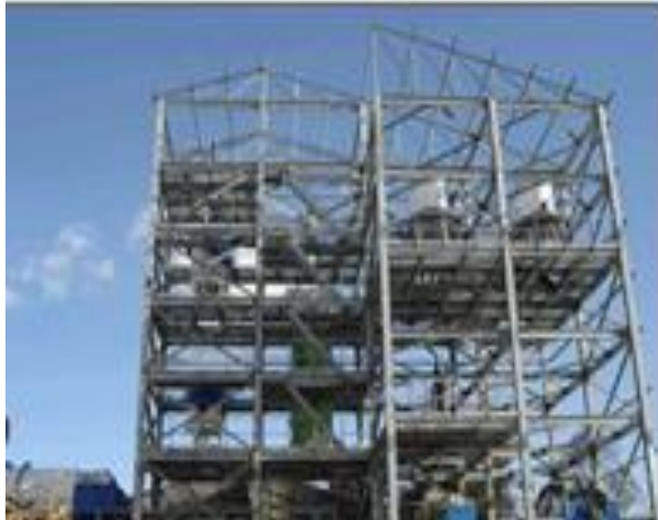
Imagen 12. Edificios en estructura.
