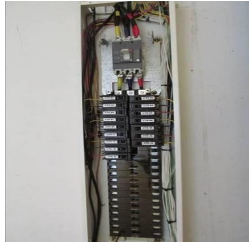
Fotografía 31. Conexionado del tablero del Bloque 4C
