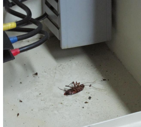
Fotografía 65. Conexionado del tablero Regulado SE Bloque 9
