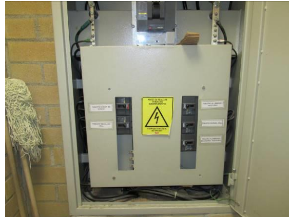
Fotografía 47. Conexión del tablero del Bloque 7
