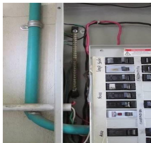
Fotografía 33. Conexión del tablero del Bloque 4D
