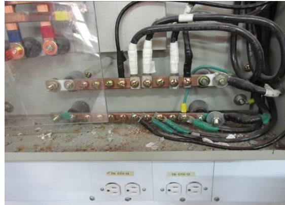
Fotografía 35. Conexión del tablero del Bloque 4E
