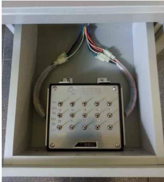
Figura 21. Conexión de caja de fallas con el cableado del sistema.
