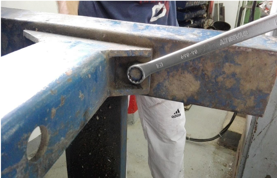
Imagen 9. Desmonte de piezas defectuosas.
