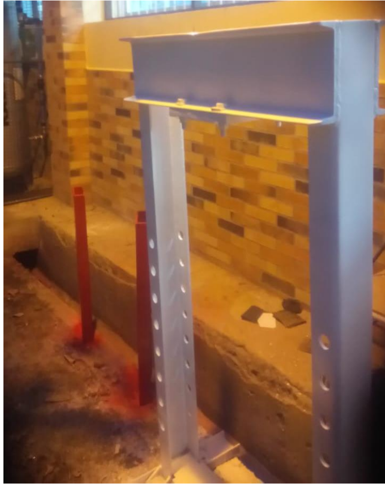
Imagen 16. Mesa de trabajo y estructura pintada.
