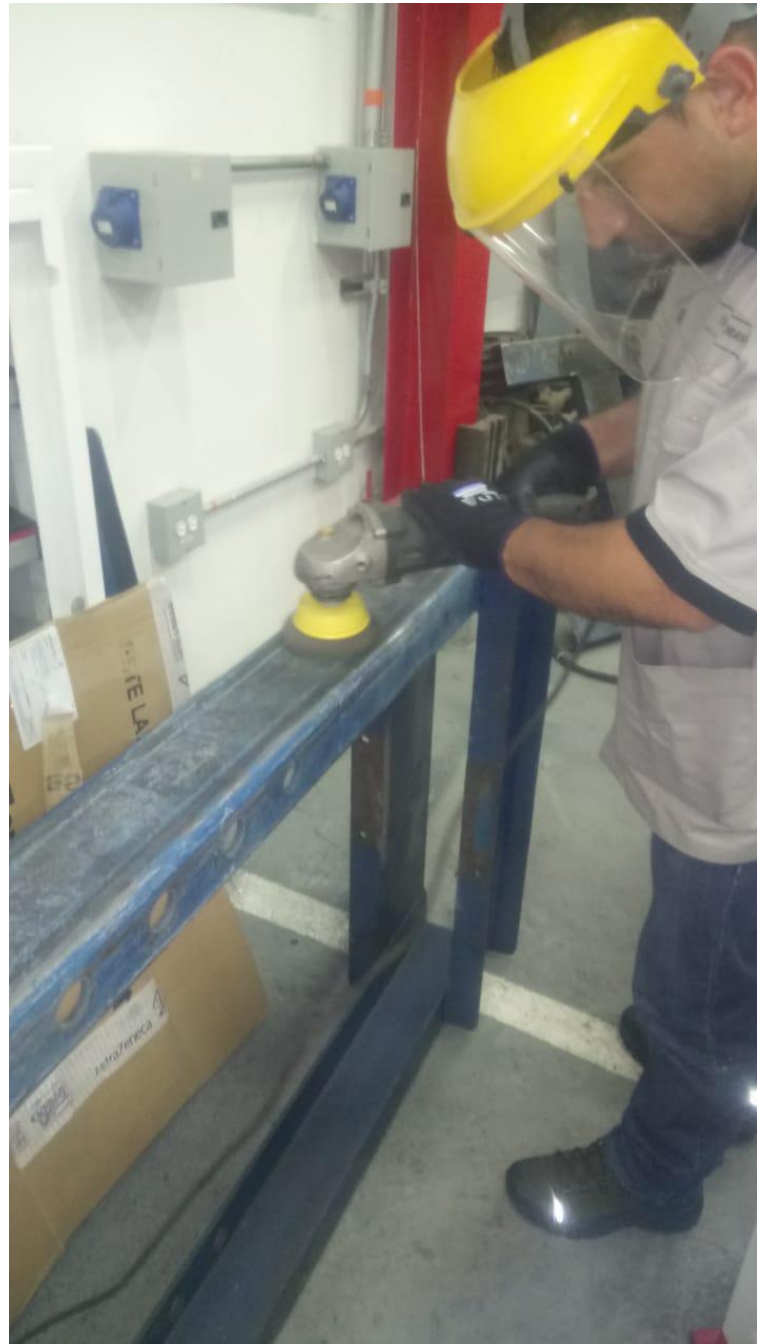
Imagen 12. Remover pintura de la estructura.
