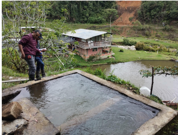
Figura 17. Imagen del tanque desarenador y sitio de construcción del tanque de carga
