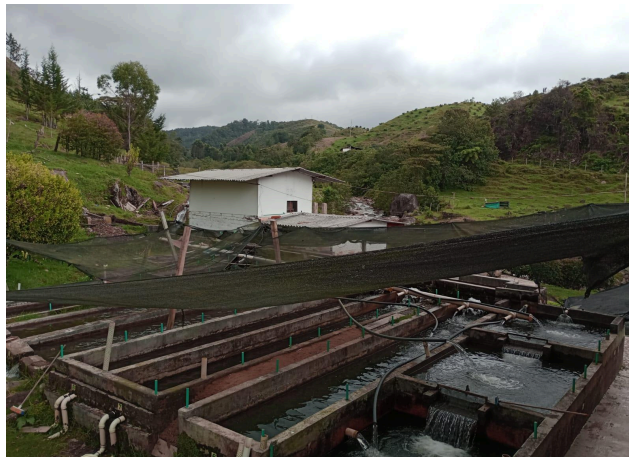
Figura 22. Imagen. Sitio tentativo para ubicar los paneles solares.
