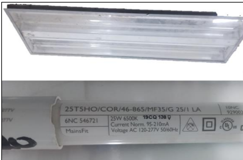
Figura 11. Luminaria T5 25w
