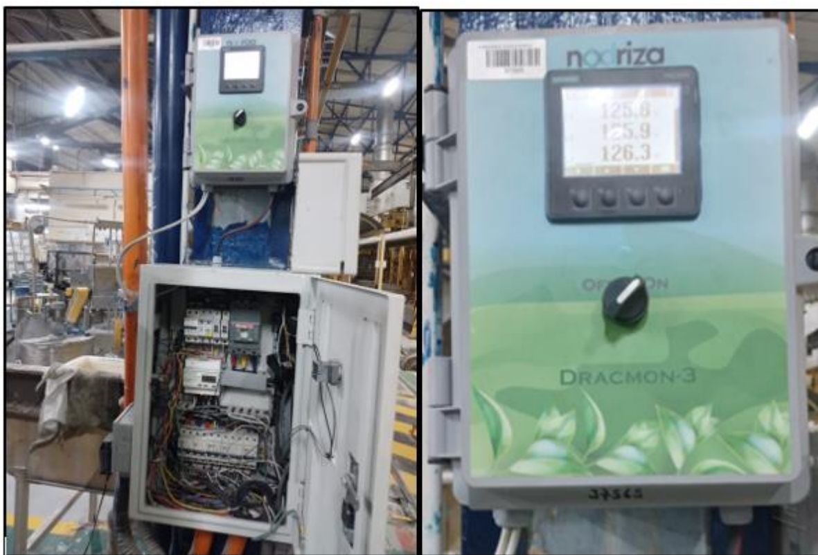
Figura 24. Instalación de medidor de energía
