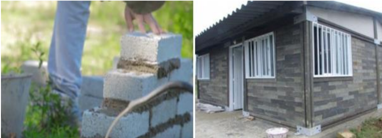
Figura 13. Proceso de construcción de viviendas con ladrillos fabricados de una mezcla de plástico y cemento portland: a) Unión con cemento; b) Casa terminada.
