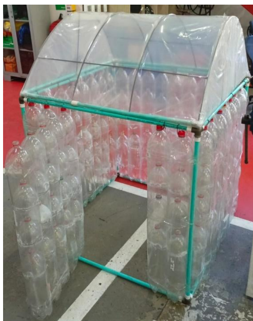
Ilustración 2 Invernadero Verde. Elaborado con botellas PET Fuente. Propia
