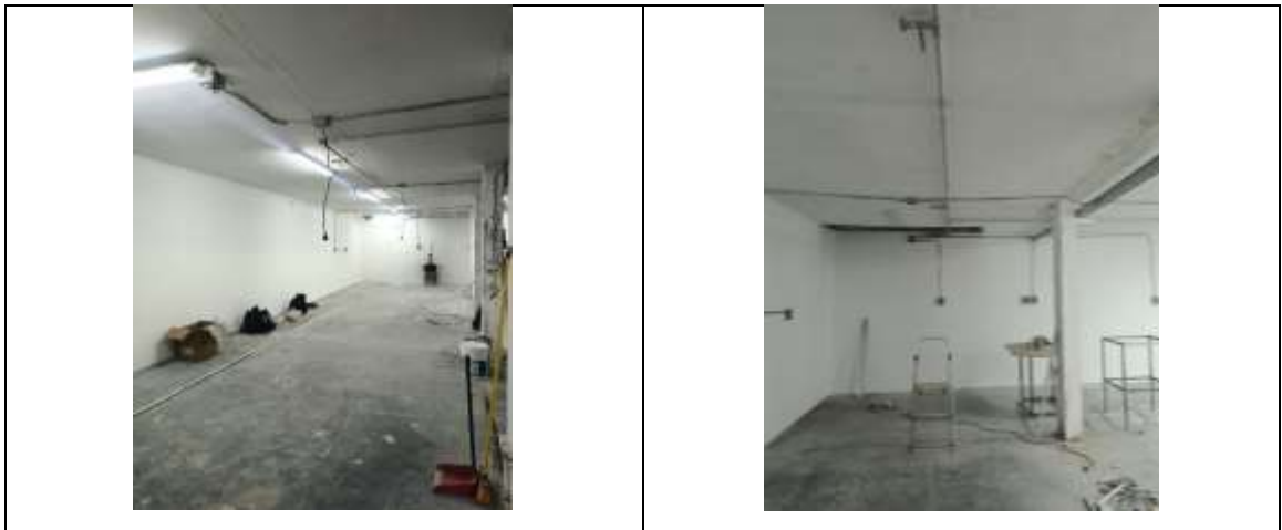
Figura 11 Instalación sistema Eléctrico y Neumático
