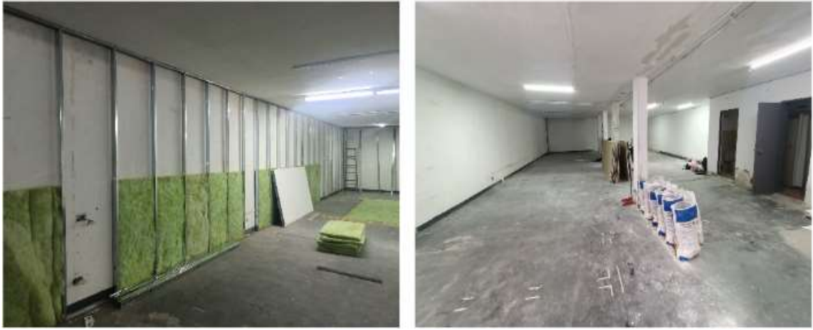
Figura 10 Adecuaciones planta nueva
