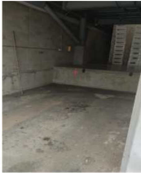
Orden y aseo en el área de cargue y descargue.
