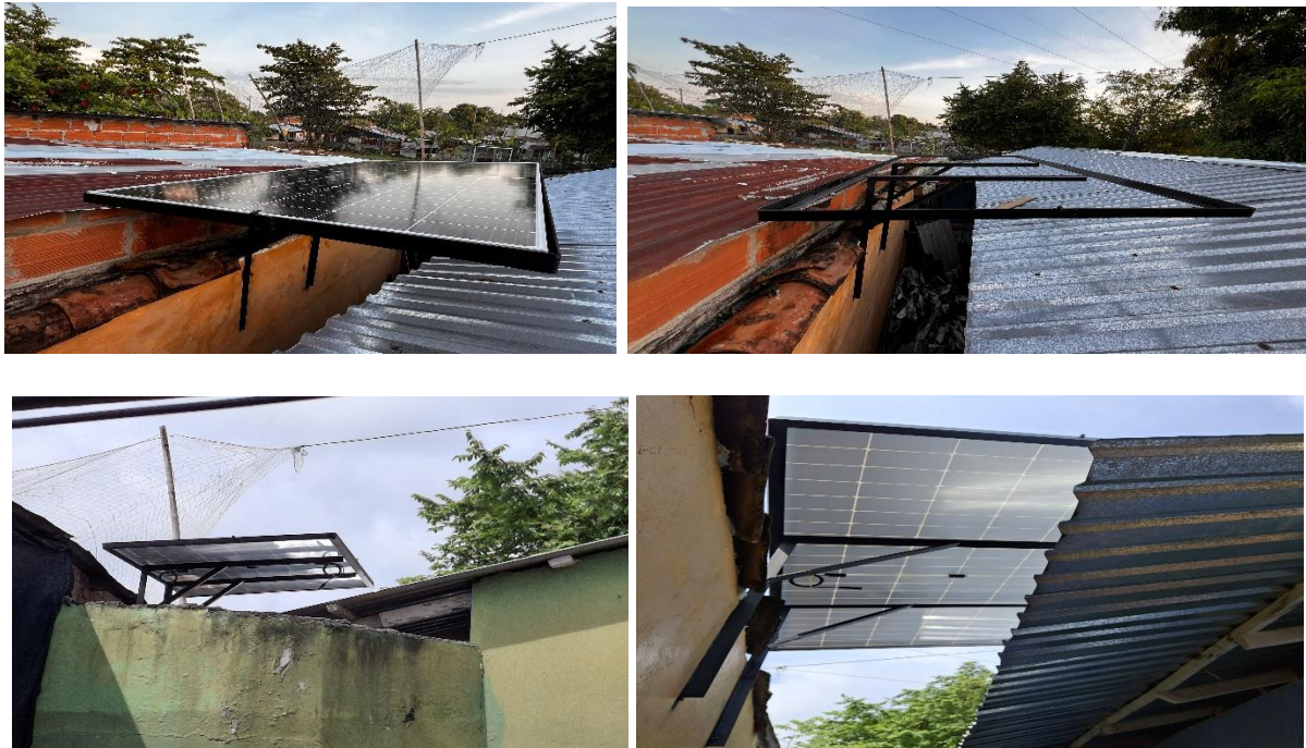
Ilustración 28: Instalación del panel solar.
