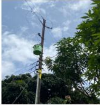
Imagen Punto salida Del diseño redes existentes Forma a quedar en terreno En figura 3
