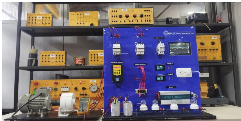
Figura 25 Verificación del módulo para prueba bajo carga Fuente: (Diseño por Romario Illera, Jonathan Mesa, Carlos Marin)
