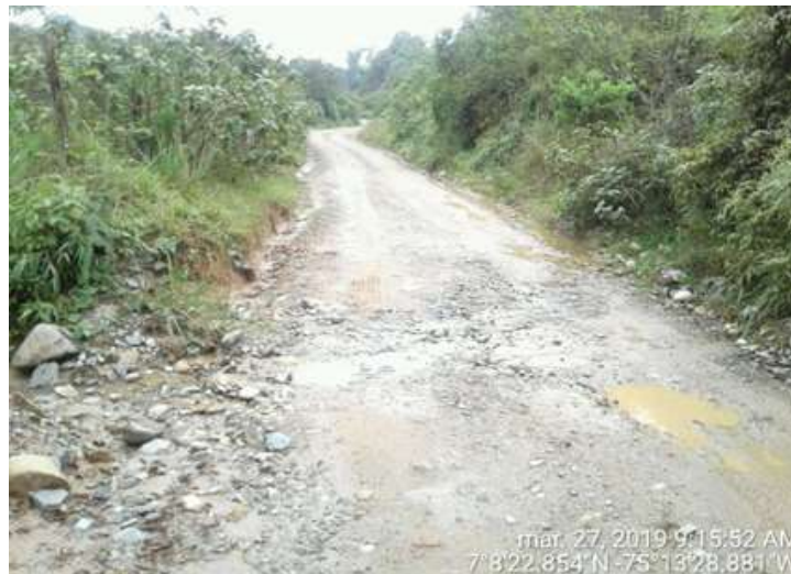
Fotografía 6 Punto crítico que requiere perfilación
