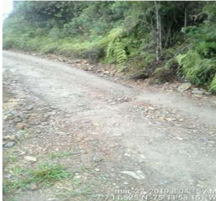
Fotografía 3 Punto de la vía que requiere construcción de alcantarilla
