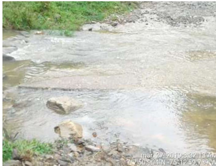
Fotografía 2 Cruce de cuerpo de agua sobre la vía
