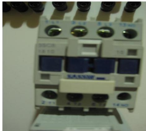
**Figura 19. Contactor electromagnético**
