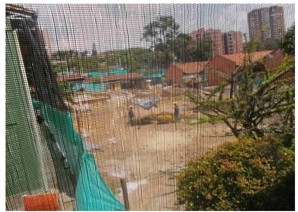
FOTO 9. LABORES DE CONSTRUCCIÓN.
