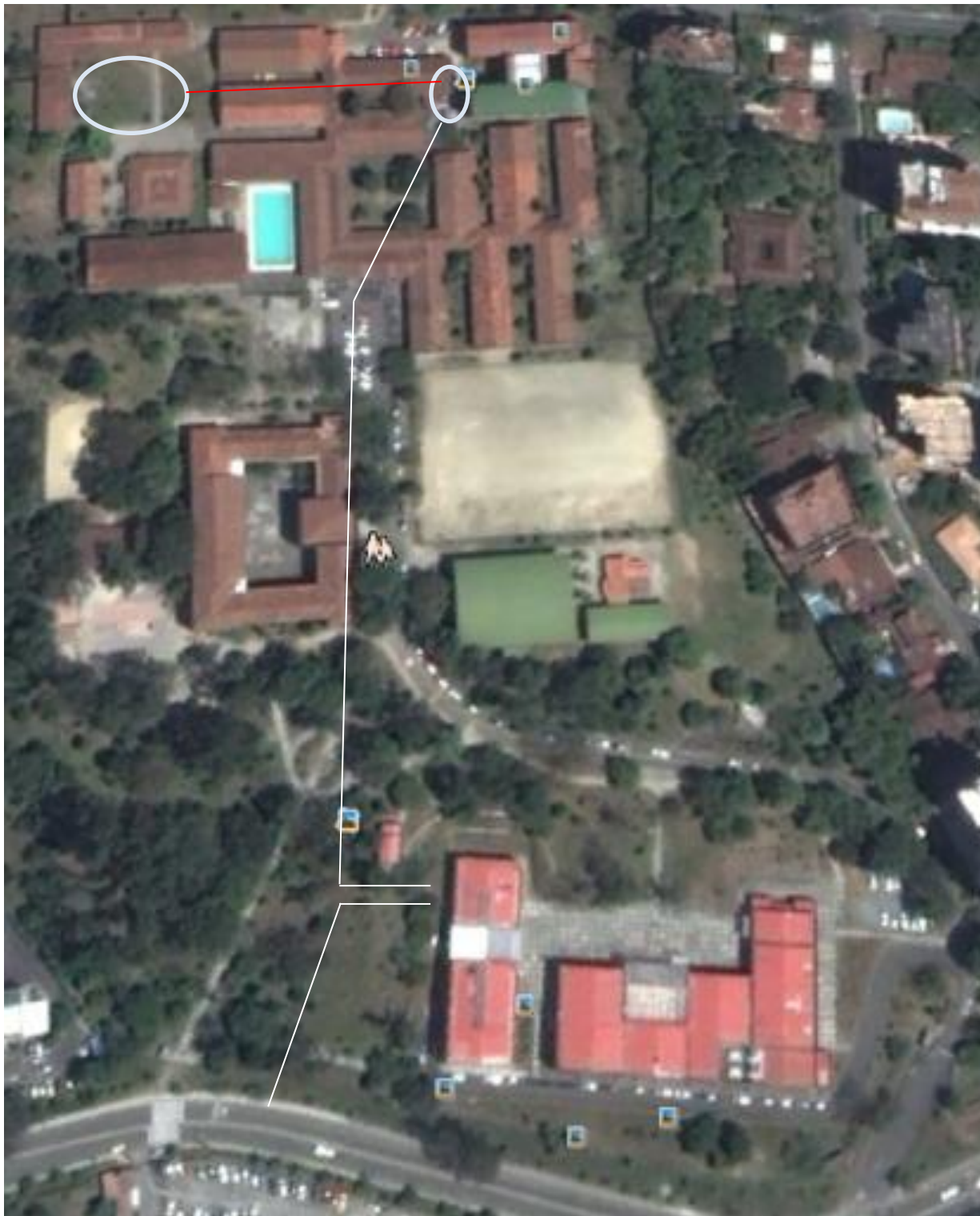
Foto 1. Trayectoria línea media tensión existente (blanca) y futura (roja), lote donde quedará ubicado el nuevo bloque de aulas.
