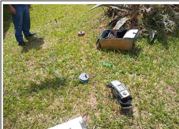
FOTO 2. DISTRIBUCIÓN CABLEADO TELURHOMETRO METREL EN TERRENO.
