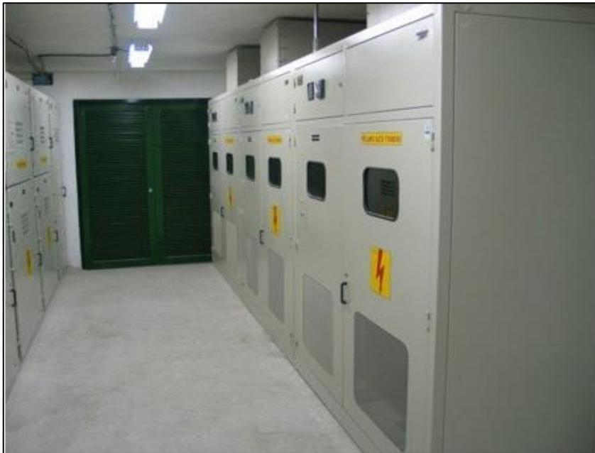
Figura 6. Vista de Subestación compacta en media tensión. Tomada de [www.electricon.com](http://www.electricon.com).
