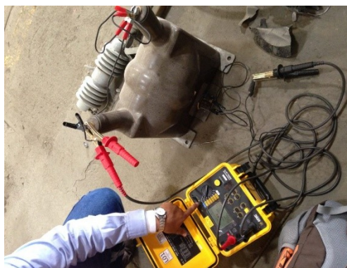
Figura 46. Transformadores de potencia (PTs)
