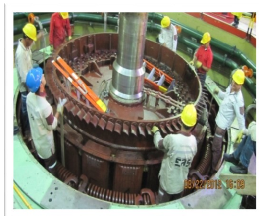
Figura 19. Rotor de polos salientes entrando al Estator (R.K)
