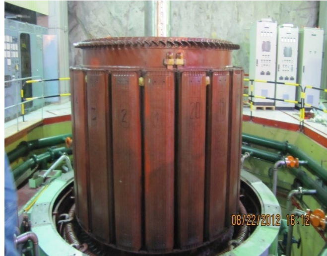
Figura 10. Rotor Generador Central hidroplayas Fuente extraído de Central Hidroeléctrica de Playas
