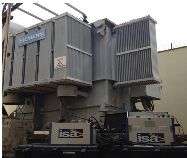
Figura 43. Pruebas Transformadores de Potencia
