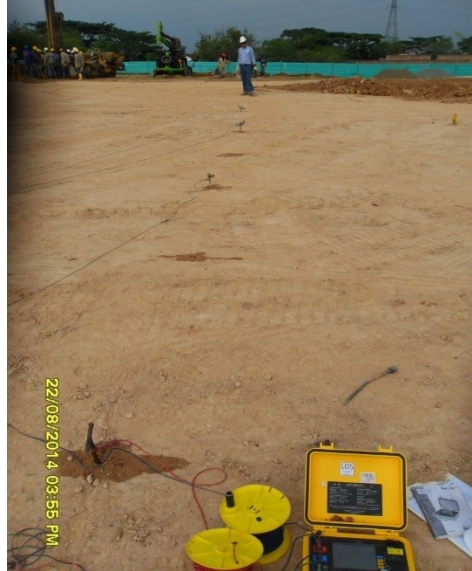
Figura 49. Medición de Sistemas de puesta a tierra
