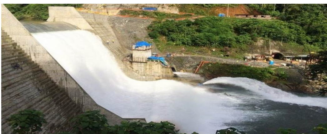
Figura 3. Central Hidroeléctrica BONYIC (EPM Panamá)
