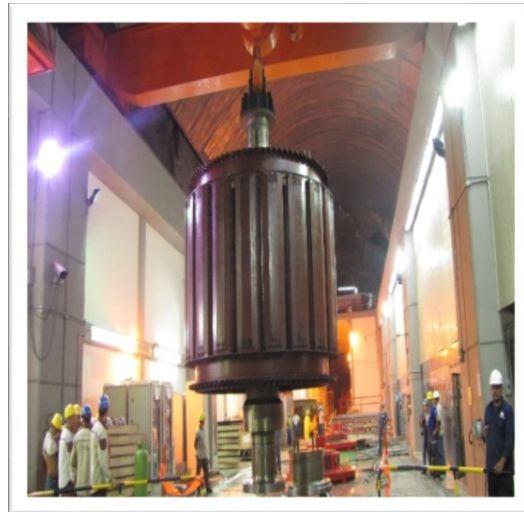
Figura 9. Rotor de polos salientes (R.K) Central Hidroeléctrica de Playas EPM Fuente extraído de Central Hidroeléctrica de Playas
