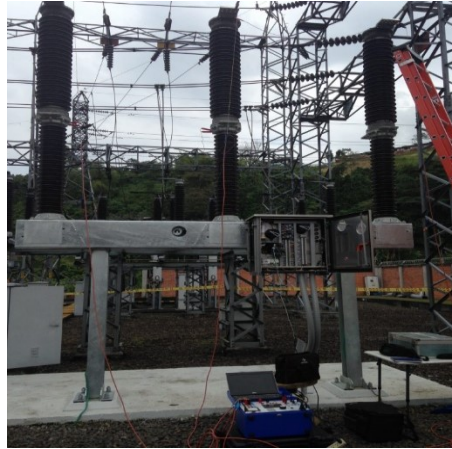
Figura 47. Pruebas en interruptores BT, MT y AT (baja, media, alta tensión Fuente: extraido de http://pti-sa.com.co/pruebas-a-interruptores/
