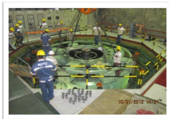
Figura 21. Acople superior (Araña) al estator (R.K)
