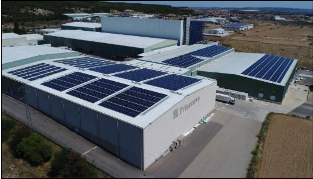
Imagen 3: ejemplificación de industria a base de energía solar
