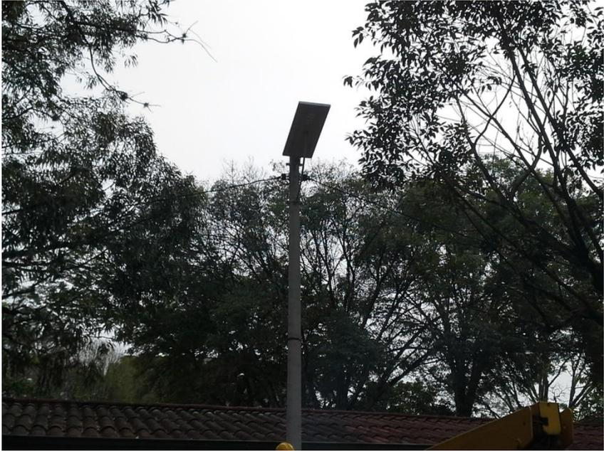
**Anexo 13. Fotografía Luminarias LED solar instaladas en el poste central adaptado en el parqueadero**
