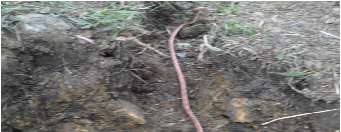
Figura 12. Instalación de cable
