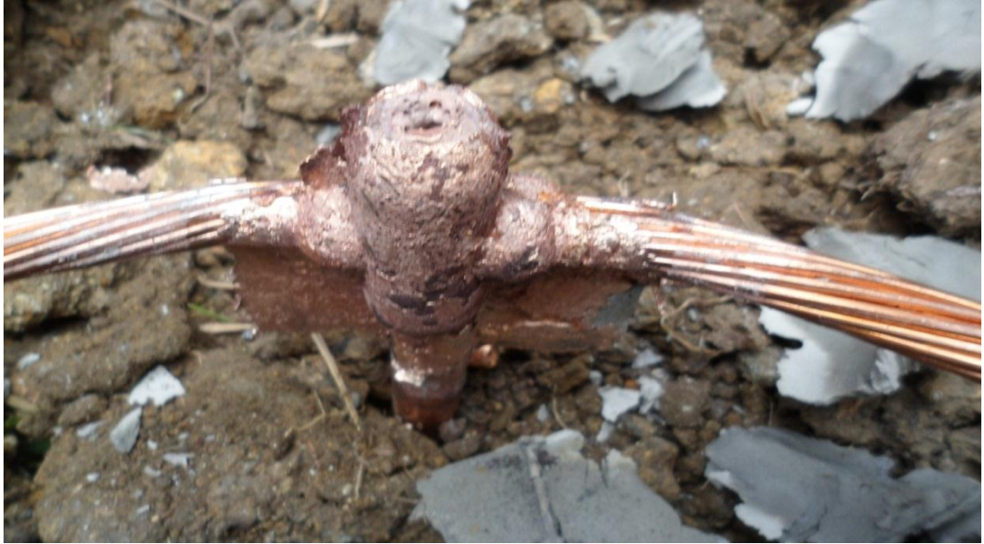
Figura 18. Soldadura terminada.
