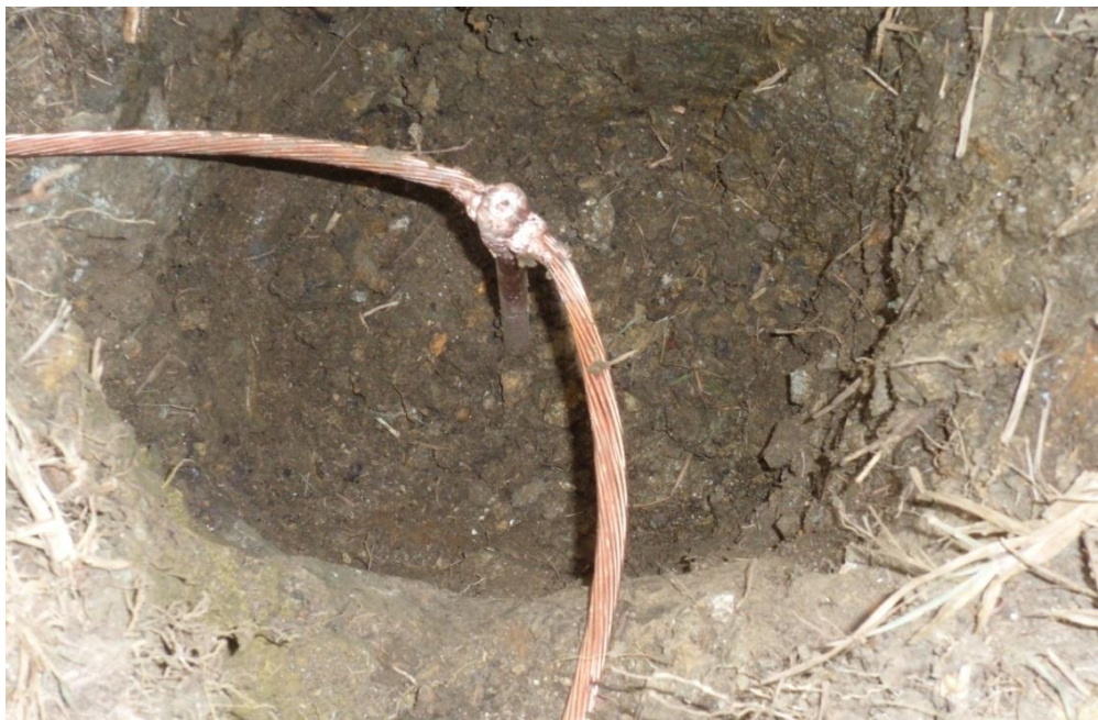
Figura 19. Soldadura totalmente terminada.
