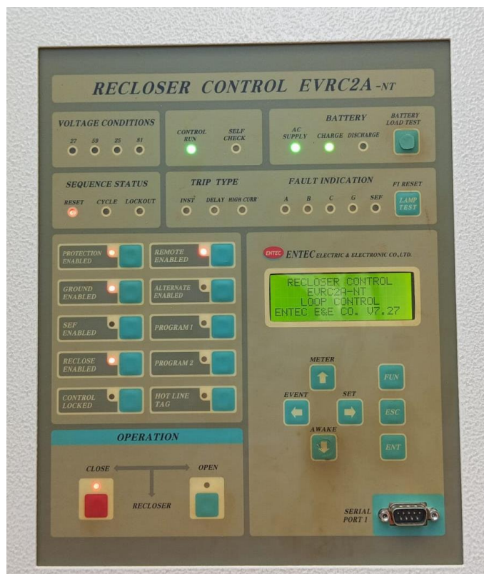
Figura 8. Relé del Control Reconectador
